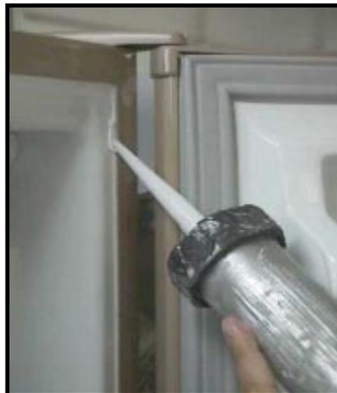
Aplique uma fina camada de silicone ( + ou - 2 mm ). Após aplicação dê o acabamento final.
