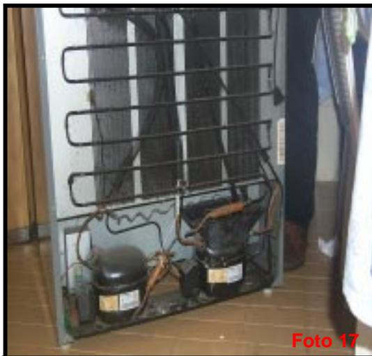
16 - Ajuste o Tubo de Drenagem em direção da Bandeja de Evaporação. Corte-o se necessário para que ele fique próximo a Bandeja. Prenda-o no Condensador usando a **Cinta de Amarração 03.1630.10.0** e finalmente fixe o Condensador. (**Foto 17**) Após isso estará pronta a transformação.
