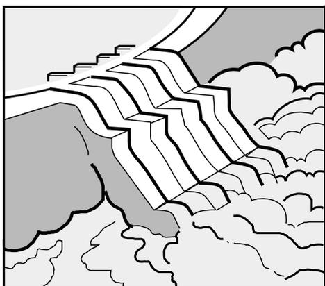
**a) Geração:** - A energia elétrica é produzida a partir da energia mecânica de rotação de um eixo de uma turbina que movimenta um gerador. Esta rotação é causada por diferentes fontes primárias, como por exemplo, a força da água que cai (hidráulica), a força do vapor (térmica) que pode ter origem na queima do carvão, óleo combustível ou, ainda, na fissão do urânio (nuclear).
