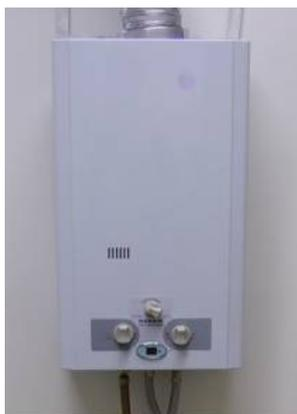
Figura 18: Aquecedor de passagem
