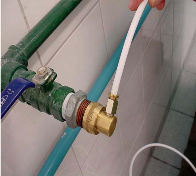
2) Após inserir a mangueira, aperte a rosca usando uma chave adequada isso vai garantir a conexão sem vazamentos da mangueira.
