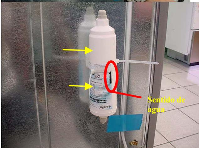
4) Corte a mangueira na distancia suficiente ate chegar ao filtro, em seguida insira a mangueira na entrada de água no filtro e empurre para dentro. Um sistema de engate rápido travará a mangueira no interior do filtro. Cuidado para NÃO ligar errado, veja o sentido do fluxo de água que esta impresso no filtro.
